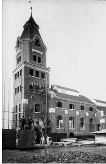
...und der des Reutlinger Gaswerks. Apparategebäude von Philipp J. Manz, Baujahr 1909.
