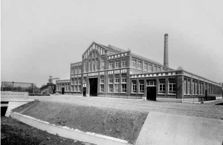
Der Hallenbau für die Zentralwerkstatt von Philipp J. Manz, Baujahr 1908/1909.
