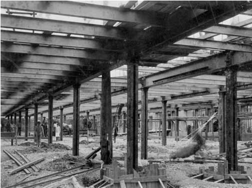
Baustelle Spinnereigeschossbau 1903. Das Büro Manz kontrollierte mit derartigen Fotos den Baufortschritt.
