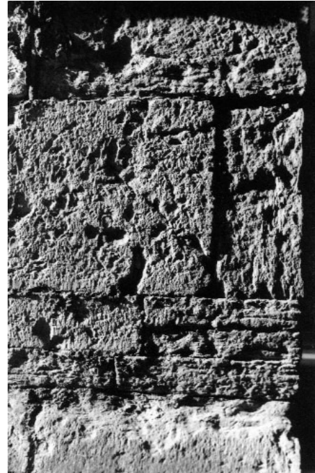
119-121 Kloster Le Thoronet, August 1965 Foto: Jean Clerc »Les pierres sauvages« Blick in den Innenhof, Kreuzgang (Nachlass GCL)
