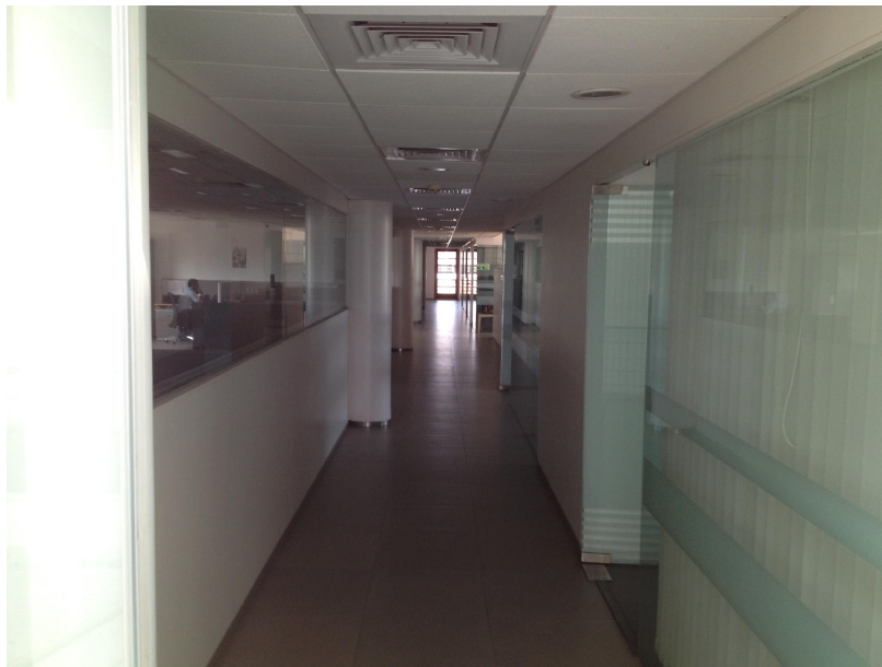
(Abb. 1 Gang im ersten Stockwerk des Admin Blocks; eigene 2013.)
