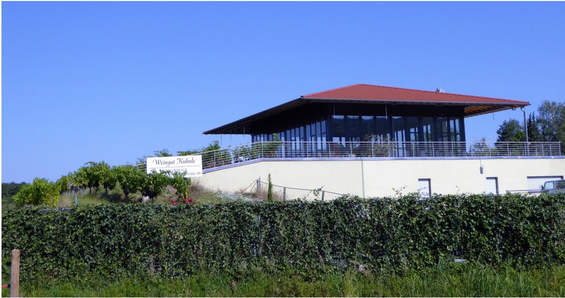
Abb. 60: Das transparente Wirtschaftsgebäude des Weinguts Kuhnle bei Strümpfelbach soll auch die „gläserne“ Produktion versinnbildlichen.
