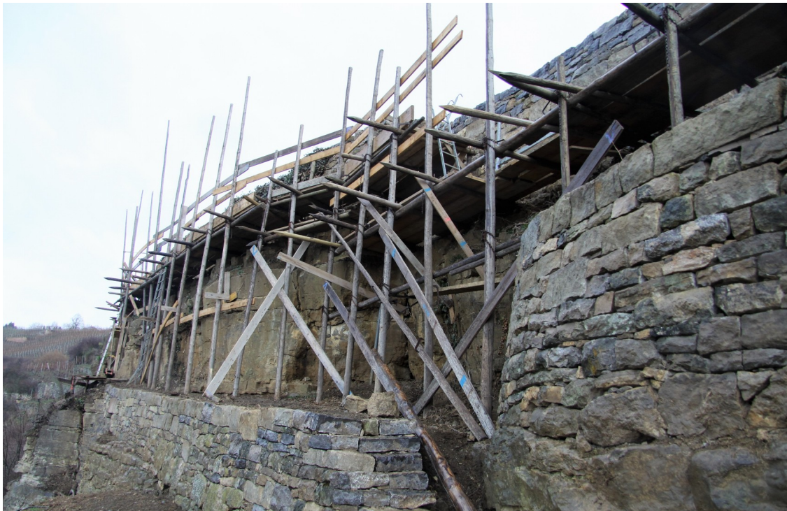
Abb. 8: Zur großflächigen Sanierung von Trockenmauern in den steilen Terrassen über der Enz wurde in Roßwag ein Baugerüst aufgestellt; bisweilen kommt sogar ein Kran zum Einsatz.
