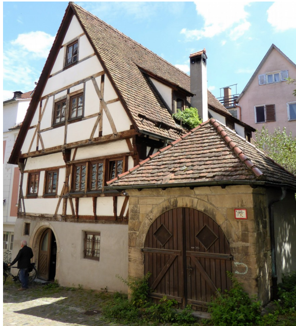
Abb. 22: Weingärtnerhaus aus dem 15. Jahrhundert in der Tübinger Altstadt. Der separate Kellereingang führt hinab in ein rund fünf Meter hohes und 12 Meter langes Gewölbe.
