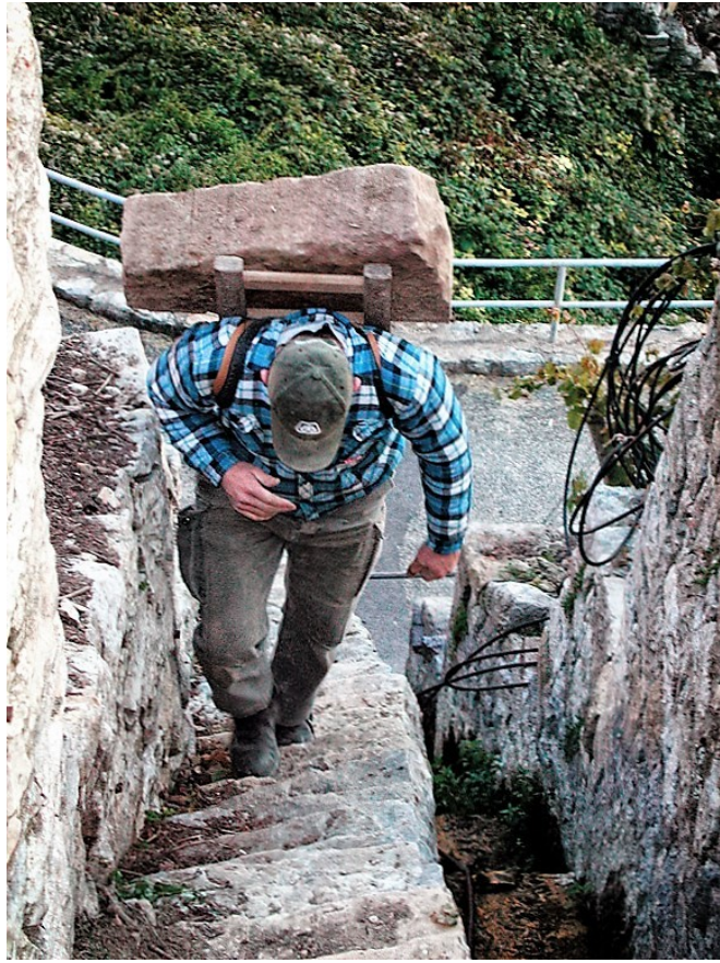
Abb. 18: Teilweise müssen die schweren Steine zur Mauersanierung mit der Rückentragung über Staffeln in die Terrassenweinberge geschleppt werden.
