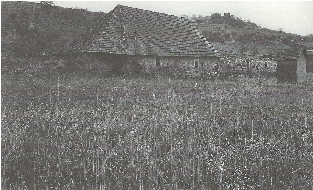
Abb. 24: Die am Fuß der Weinberge stehende Tübinger Buckenlohkelter wurde 1965 abgerissen. Hier zeigt sich die direkte Verbindung von Funktionsbauwerk und Produktionslandschaft.
