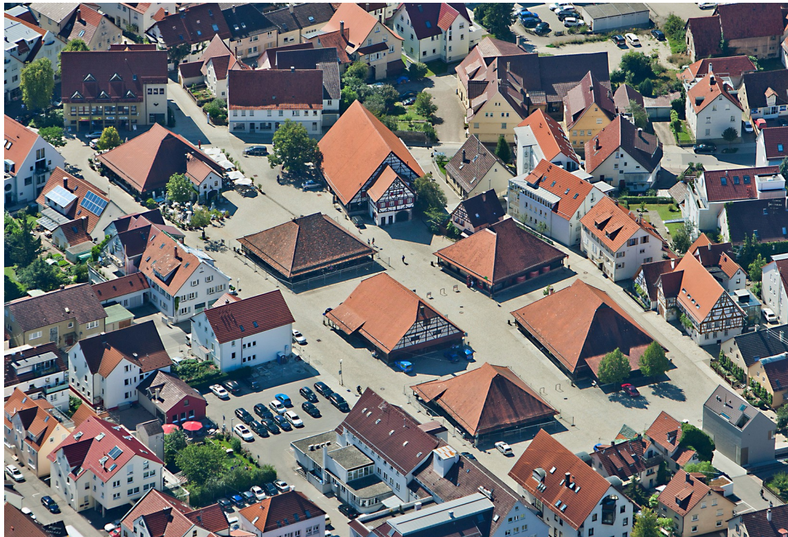
Abb. 26: Das Ensemble der Sieben Keltern in Metzingen.
