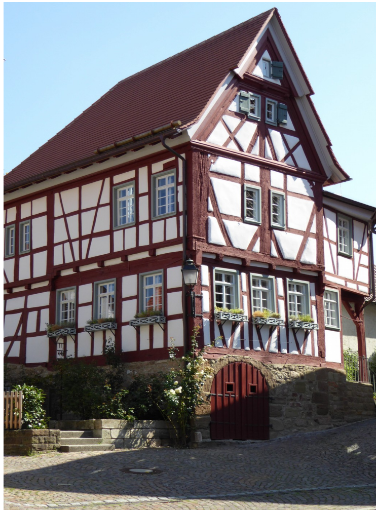
Abb. 23: Dieses imposante denkmalgeschützte Weingärtnerhaus aus dem 17. Jahrhundert in Strümpfelbach dient heute als Heimatmuseum. Über dem steinernen Unterstock mit Kellereingang erhebt sich ein dreigeschossiger Fachwerkteil.
