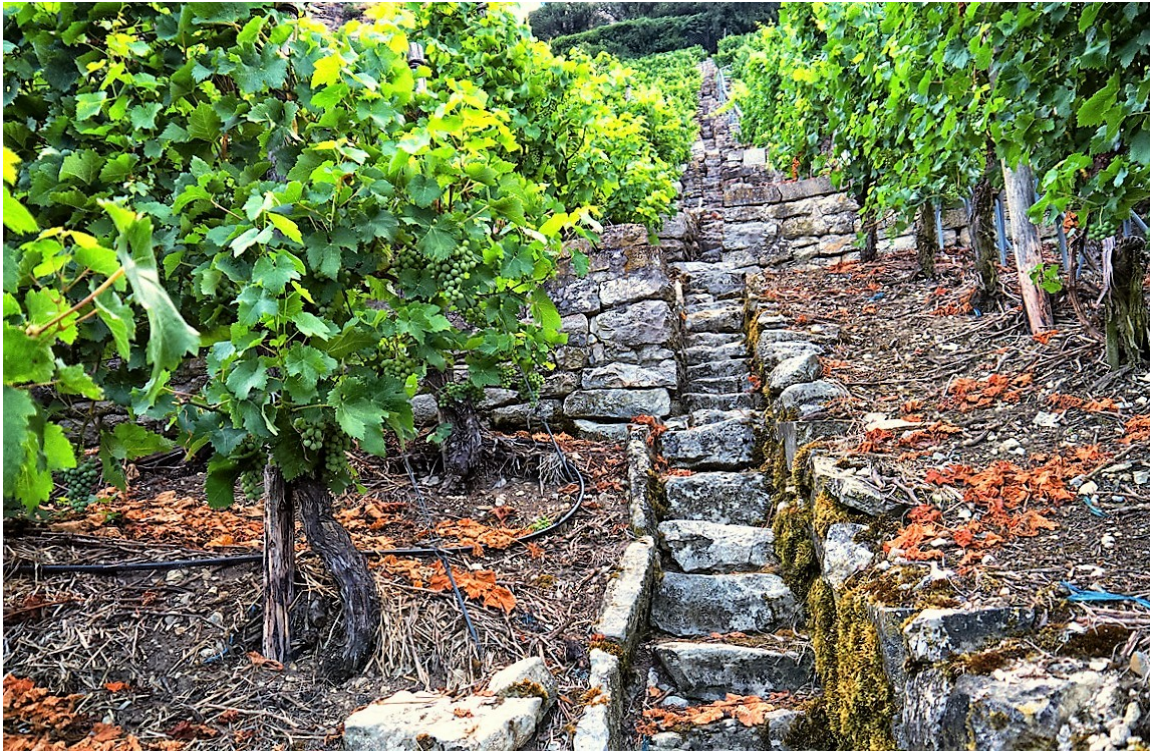
Abb. 6: Das "Gestäffel", wie die Weinbergstaffeln in Württemberg heißen, dient der Begehung und Wasserableitung.
