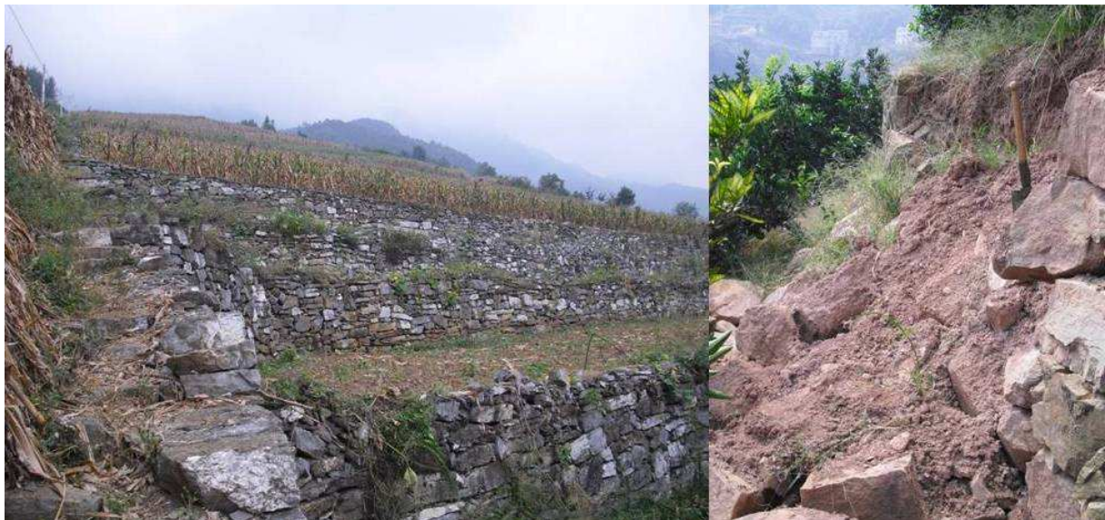
Abbildung 15 Terrassendesign und Erosionsschäden im Einzugsgebiet des Xiangxi. Parallel verlaufende Level bed-Terrassen im guten Zustand in Huang Liang Ping, Fläche E_5 (links) und durch Bodenerosion zerstörte Trockensteinmauern auf einer Terrasse im Teileinzugsgebiet Xiangjiaba, Fläche E_21 (rechts). Fotos aufgenommen von S. Schönbrodt (09/2008).
