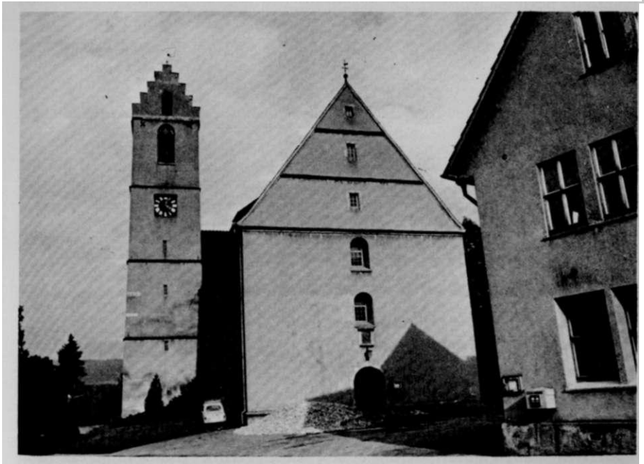
Abb. 4. Die Aldinger Mauritiuskirche von Westen vor der Renovierung. Turm erbaut 1593, Schiff erbaut 1720.
