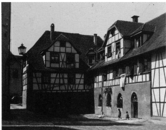
Die 1974 abgebrochenen Gebäude des ehemaligen Spitalhofs. (Siehe auch Seite 67.)
