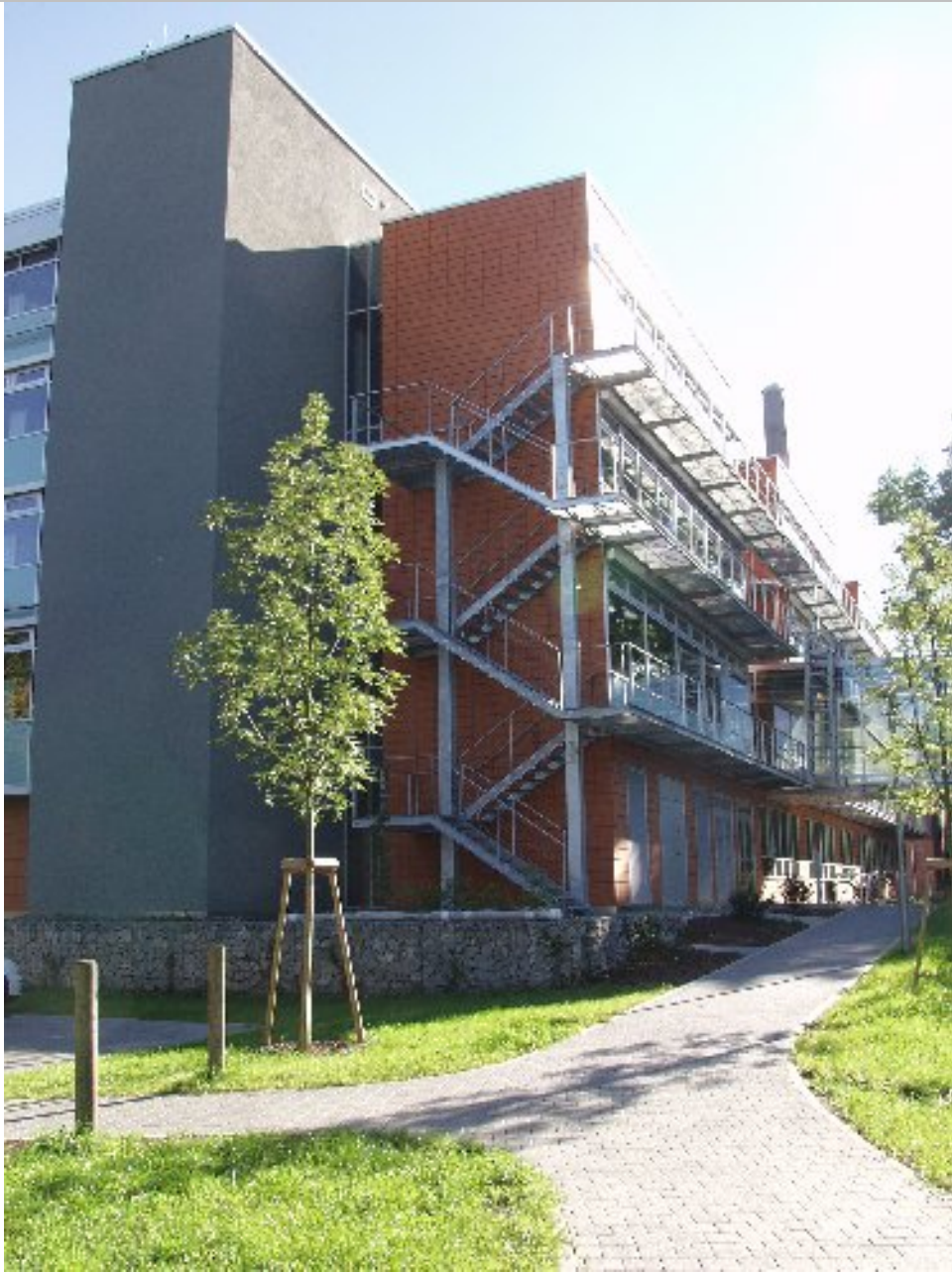
Ammerbau aussen Blick von Parkhaus
