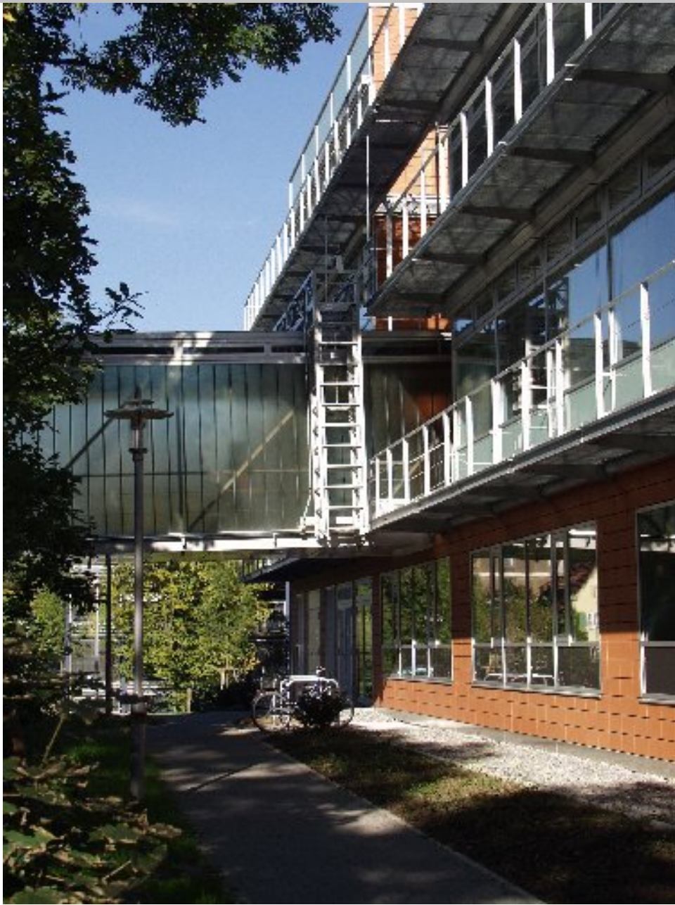
Ammerbau aussen Blick von Reprstelle
