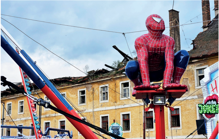
Abbildung 16: Die verfallende Festungsarchitektur zeichnet sich 2024 besonders deutlich bei der Dresdner Kaserne ab. Das Foto zeigt diese größte Kaserne der ehemaligen Festungsstadt im Hintergrund. Das Dach des gelb verputzten Gebäudes ist erheblich beschädigt. In den Vordergrund drängten aktuelle Bedürfnisse der Tereziner*innen, die auf dem Appellplatz vor der Kaserne einen Rummel mit Fahrgeschäften für die Feier zur Stadtgründung auffahren ließen. Foto: Wolfgang Sannwald
