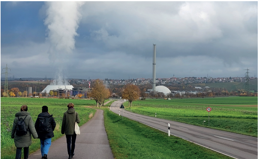
Abbildung 2: Das Kernkraftwerk Neckarwestheim ging 1976 in Betrieb und wurde am 15. April 2023 abgeschaltet. Das Kraftwerk liegt zu unterschiedlichen Anteilen auf der Gemarkung der Gemeinden Neckarwestheim (ca. 4200 Einw.) und Gemrigheim (ca. 6300 Einw.). Im Jahr 2006 wurde ein Zwischenlager für radioaktive Abfälle auf dem Gelände in Betrieb genommen. Foto: Karin Bürkert
