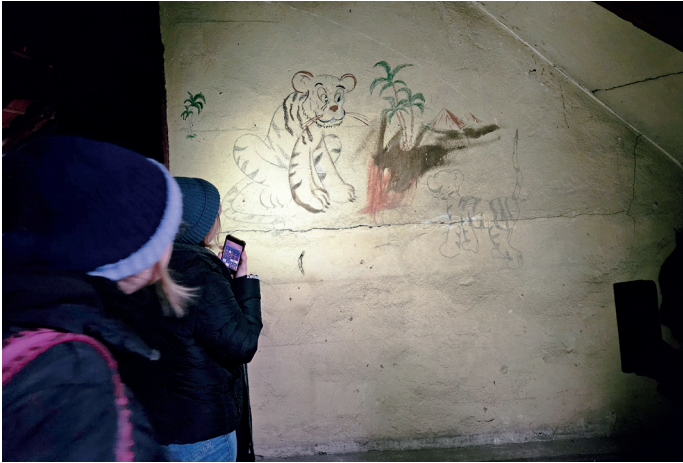
Abbildung 12: Im Haus einer Zeitzeugin finden sich diese Malereien auf dem Dachboden. Der Boden des Raumes war nach unten durchgebrochen. Foto: Wolfgang Sannwald
