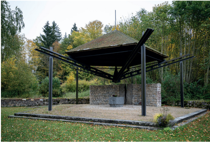
Abbildung 6: Die Gedenkstätte Grafeneck wurde 1990 in der Nähe des Friedhofs als offene Kapelle errichtet. Die stählernen Träger über dem Altar erinnern an die Dornenkrone Jesu, das Dach bildet ein Fünfeck, das an das 5. Gebot gemahnt. Foto: Carolin Albers
