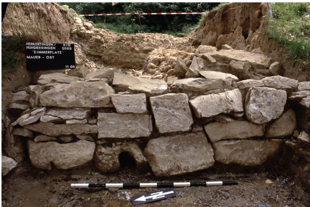
Abb. 26: Herbertingen-Hundersingen, Heuneburg. Schnitt 7/2003 „Zimmerplatz“. Profil der östlichen Trockenmauer aus behauenen Kalksteinen (Foto: Regierungspräsidium Tübingen, Ref. 26 – Denkmalpflege).
