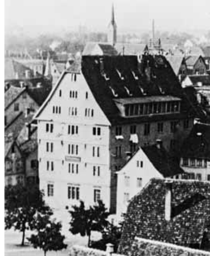
Das 1518 erbaute Spendhaus um 1912, Fotografie von Süden. Die Schleppegäuben sorgten für eine Belüftung der Fruchtböden.
