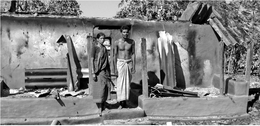
Nach den Unruhen in Orissa im Jahr 2008 – ein Bild der Zerstörung. Dieses Ehepaar hat alles verloren. Ihr Haus, ein Trümmerhaufen. Quelle: Open Doors
